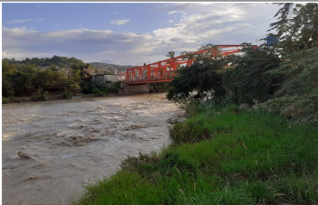
FIGURA N°01: TRAMO CRÍTICO EN EL PUENTE CAJARURO PRESENTADO EROSION EN LA MARGEN DERECHA DEL RIO UTCUBAMBA EN EL SECTOR CAJARURO, DISTRITO DE CAJARURO, PROVINCIA UTCUBAMBA - AMAZONAS.
